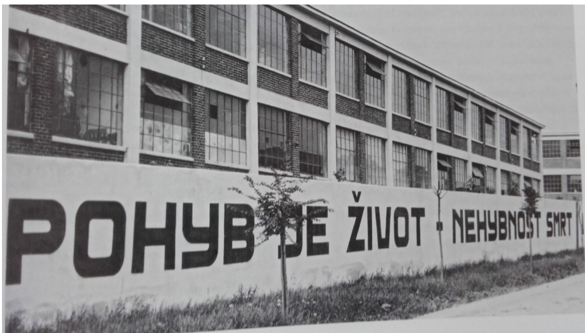
Obrázek 10 Příklad hesla na zdi budovy továrny (Pokluda a Baťa, 2014)
