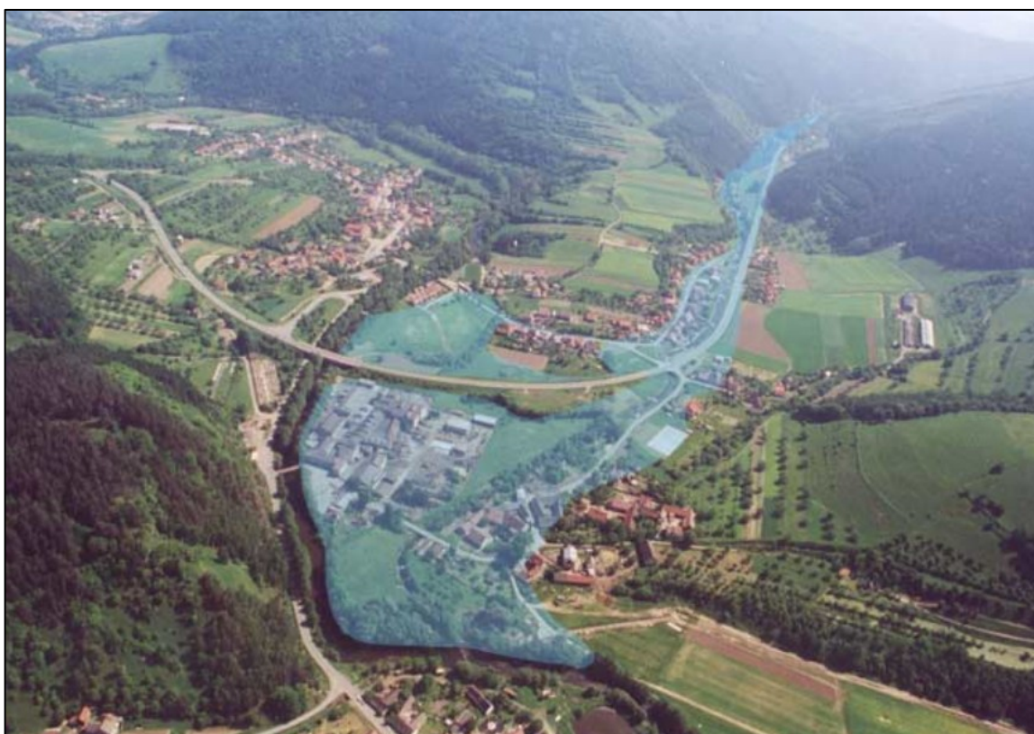
Obr. 19. Rozsah zaplaveného území Štěpánova nad Svratkou 62
