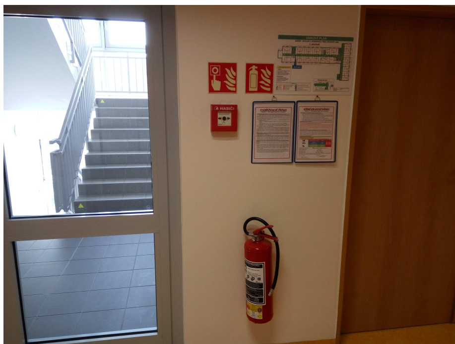
Obrázek 5 Umístění prvků požární ochrany [zdroj: vlastní]
