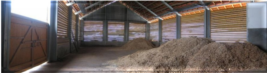
Obr. 2 Výtopna na biomasu v obci Hostětín [4]
