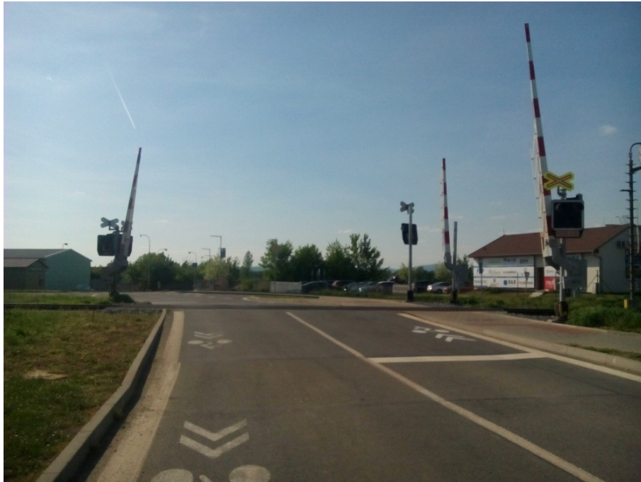
Obrázek 6: PZS s polovičními závorami v obci Ostrožská Nová Ves. [Zdroj: vlastní]
