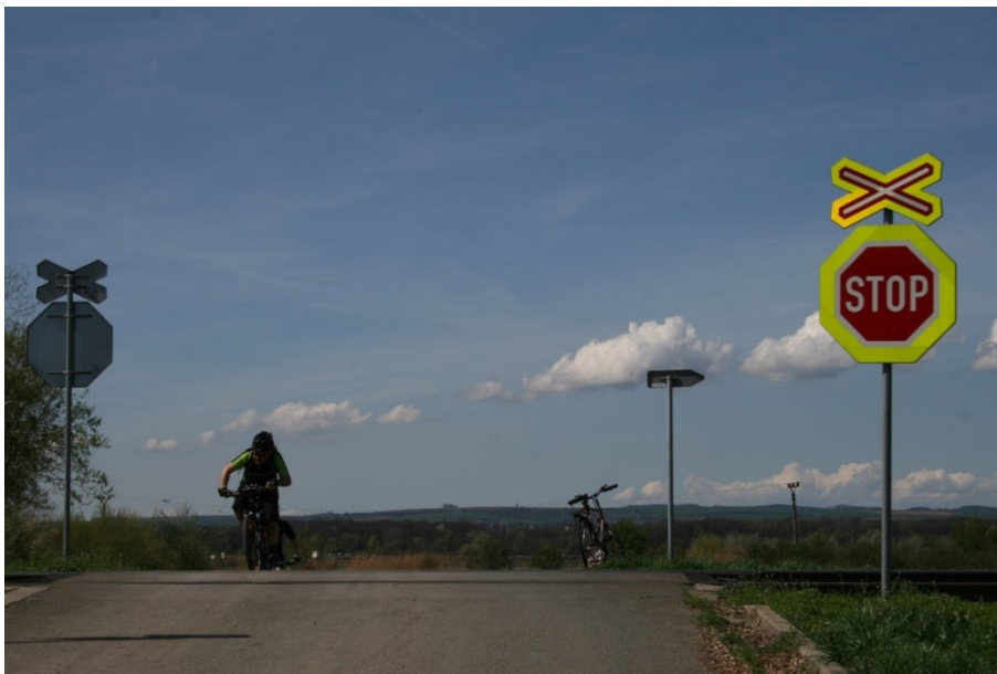
Obrázek 4: Nezabezpečený přejezd v obci Ostrožská Nová Ves.
