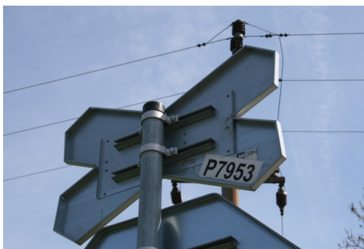
Obrázek 8: Identifikační číslo přejezdu na výstražném kříži. [Zdroj: vlastní]
