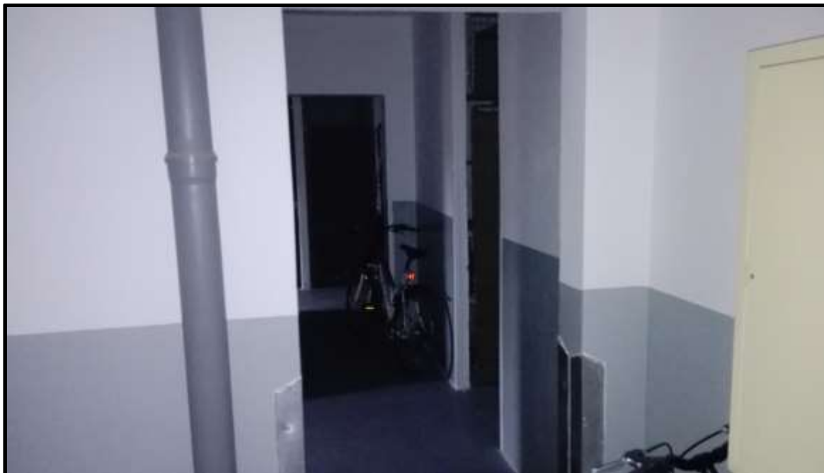
Chodba sklepních prostor domu konstrukční soustavy T06B-KDU, věžová sekce. Adresa Tř. Maršála Malinovského 880. Dům má nadzemní sklepní prostory.
