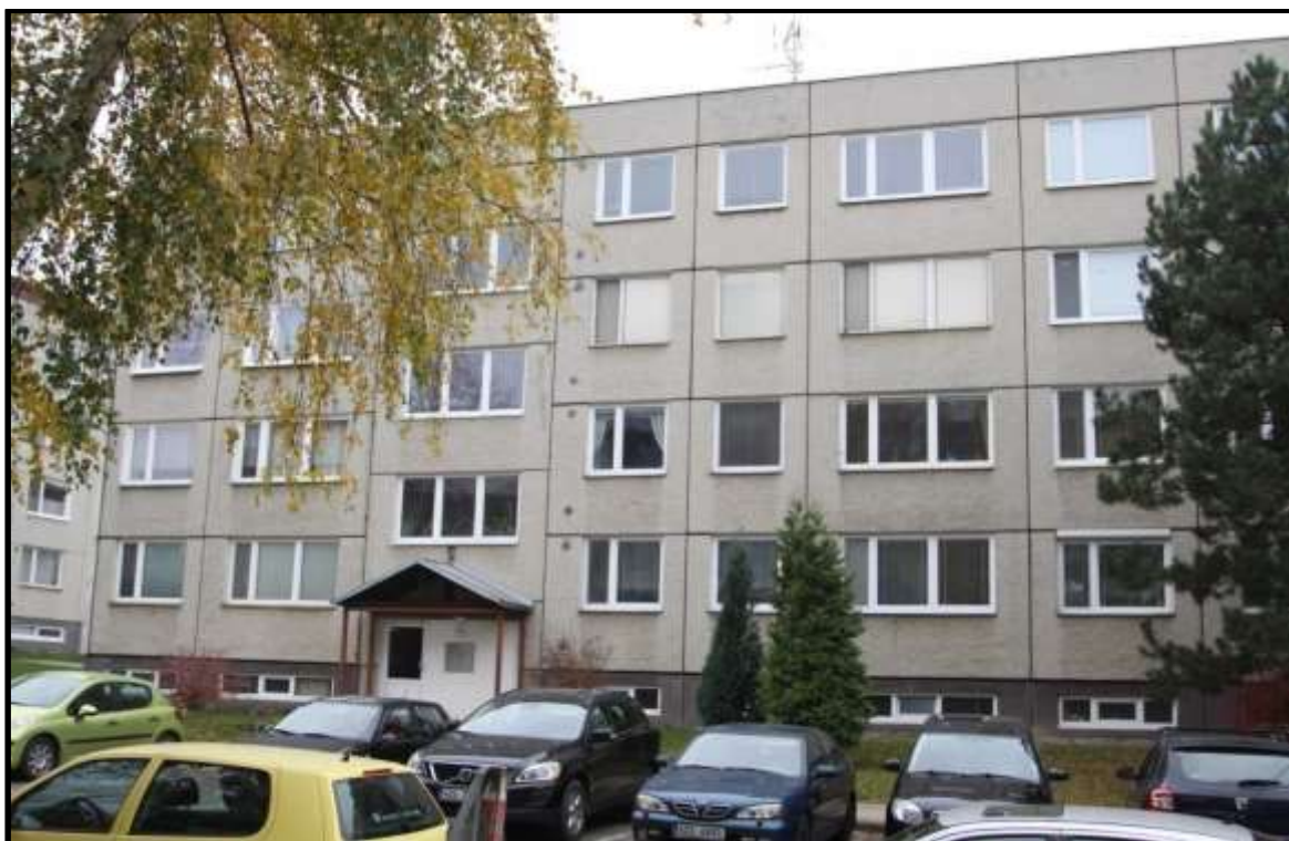
Konstrukční soustava OP1.11, řadová sekce, Dům před celkovou revitalizací vyjma nových oken. Adresa: Jaroslava Staňka 865.
