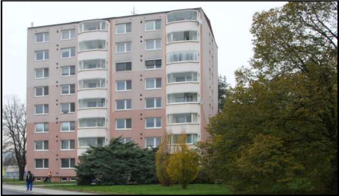
Konstrukční soustava T06B-KDU, věžová sekce. Dům po celkové revitalizaci. Adresa 28. Října 984.
