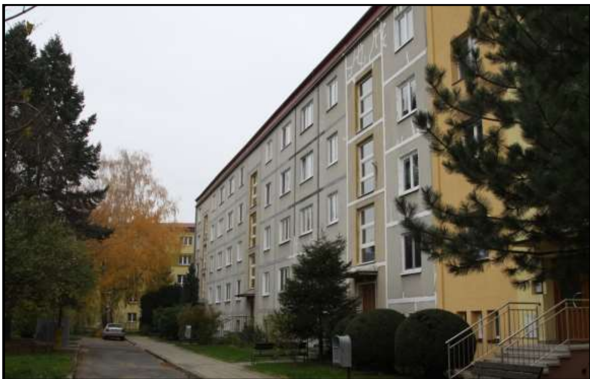
Konstrukční soustava G 57, řadová sekce. Dům se sedlovou střechou. Vyjma nových oken je dům před celkovou revitalizací. Adresa: Průmyslová 911, 912 a 913.
