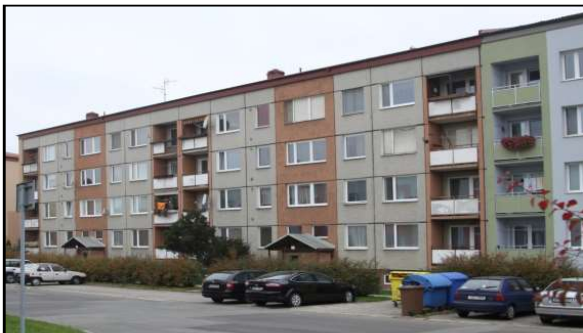
Obrázek 11 Panelový dům konstrukční řady OP1.11 – ulice Sadová [33]
