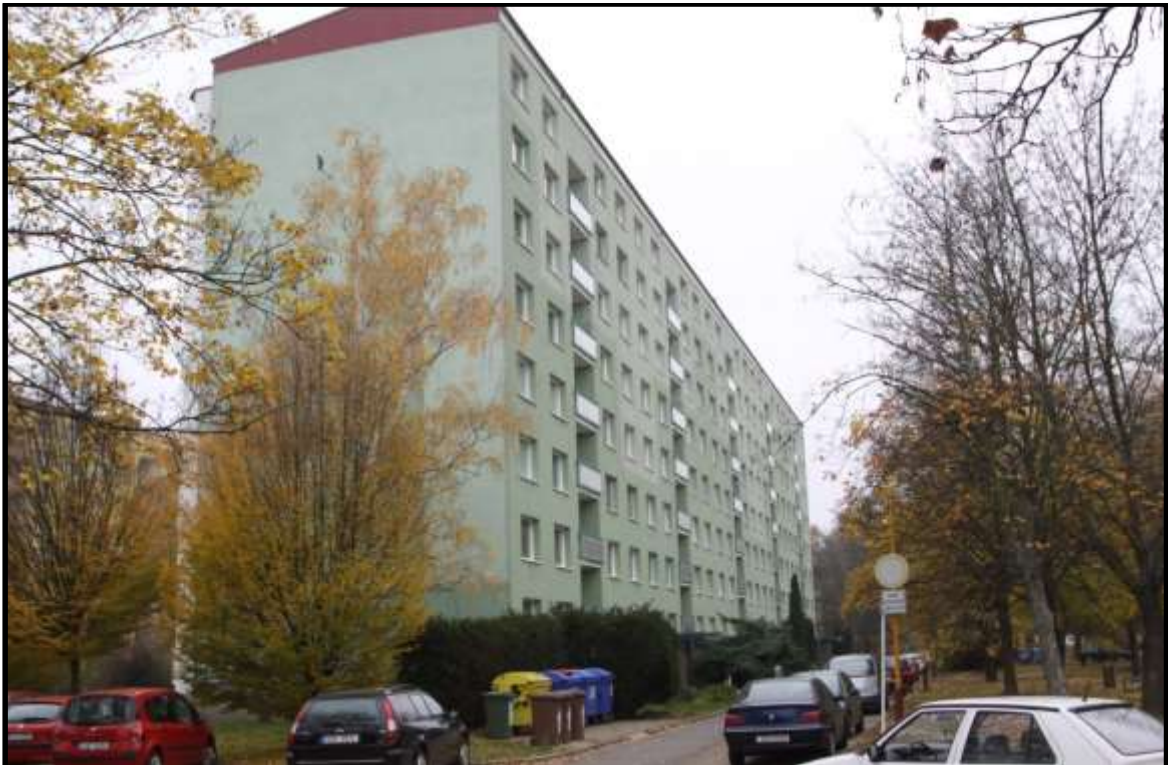
Konstrukční soustava T06B-KDU, řadová sekce. Domy po celkové revitalizaci. Adresa: Štěpnická 1051, 1052, 1053, 1054 a 1055.
