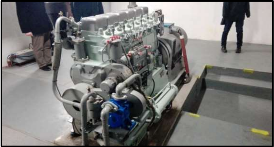
Obrázek 3 Elektrické zdrojové soustrojí ČKD AS6T-N [33]
