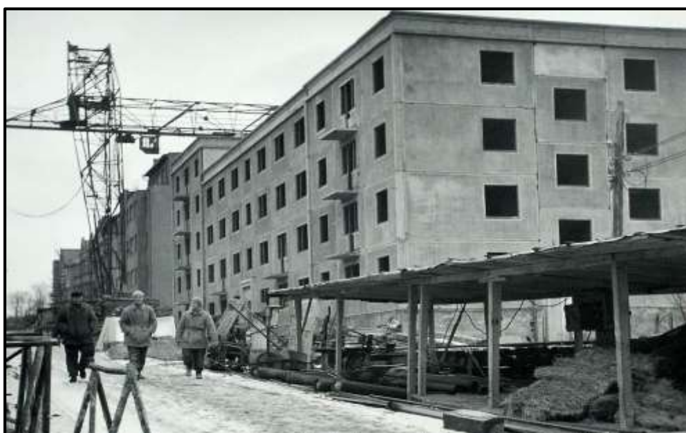
Obrázek 7 Výstavba panelového domu typu G40 [22]
