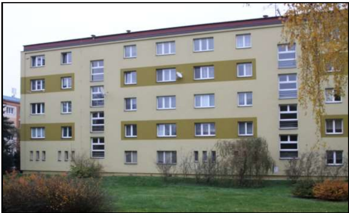
Konstrukční soustava G 57, řadová sekce. Dům po celkové revitalizaci. Adresa: Průmyslová: 899, 900 a 901.
