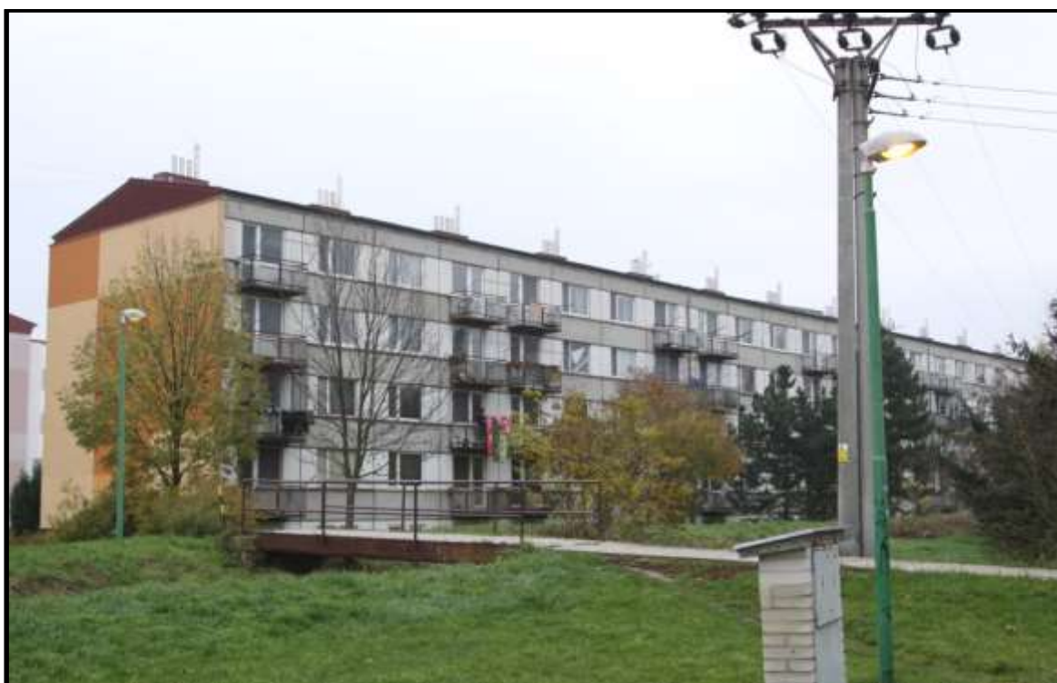
Konstrukční soustava T06B-KDU, řadová sekce. Domy se sedlovou střechou a zateplenou štitovou zdí. Adresa: 472,473,474,475,476 a 477.
