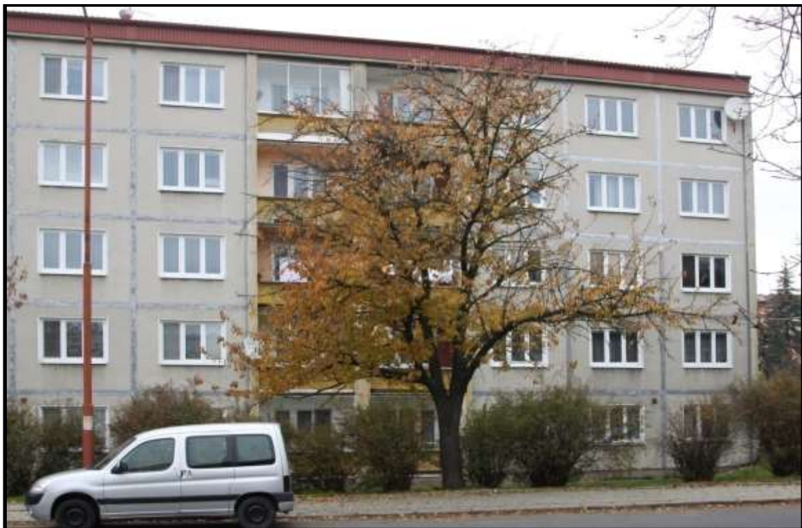
Konstrukční soustava G 57, řadová sekce. Dům se sedlovou střechou. Vyjma nových oken je dům před celkovou revitalizací. Adresa: Průmyslová 912 a 913.
