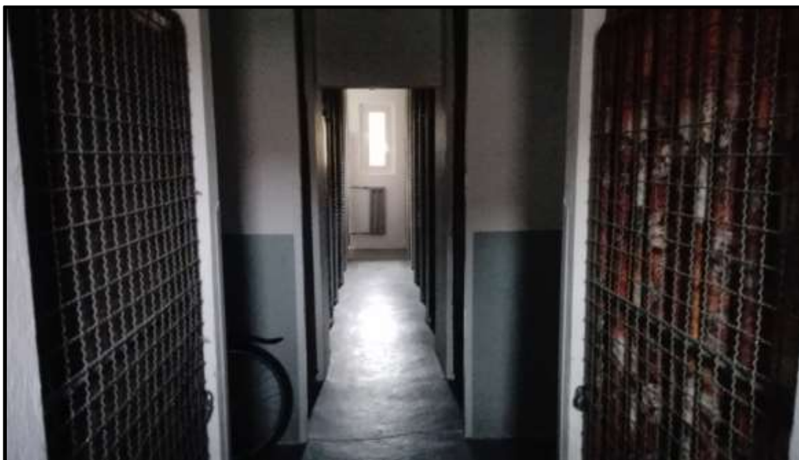
Klecové koje v domě konstrukční soustavy T06B-KDU, věžová sekce. Adresa Tř. Maršála Malinovského 880. Dům má nadzemní sklepní prostory.
