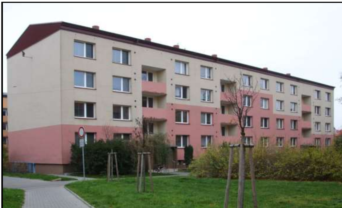
Konstrukční soustava T06B-KDU, řadová sekce. Dům po celkové revitalizaci. Adresa: Pod Svahy 997, 998 a 999.
