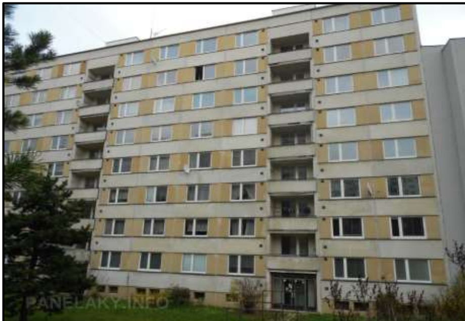
Obrázek 9 Panelový dům konstrukční řady T06B [22]
