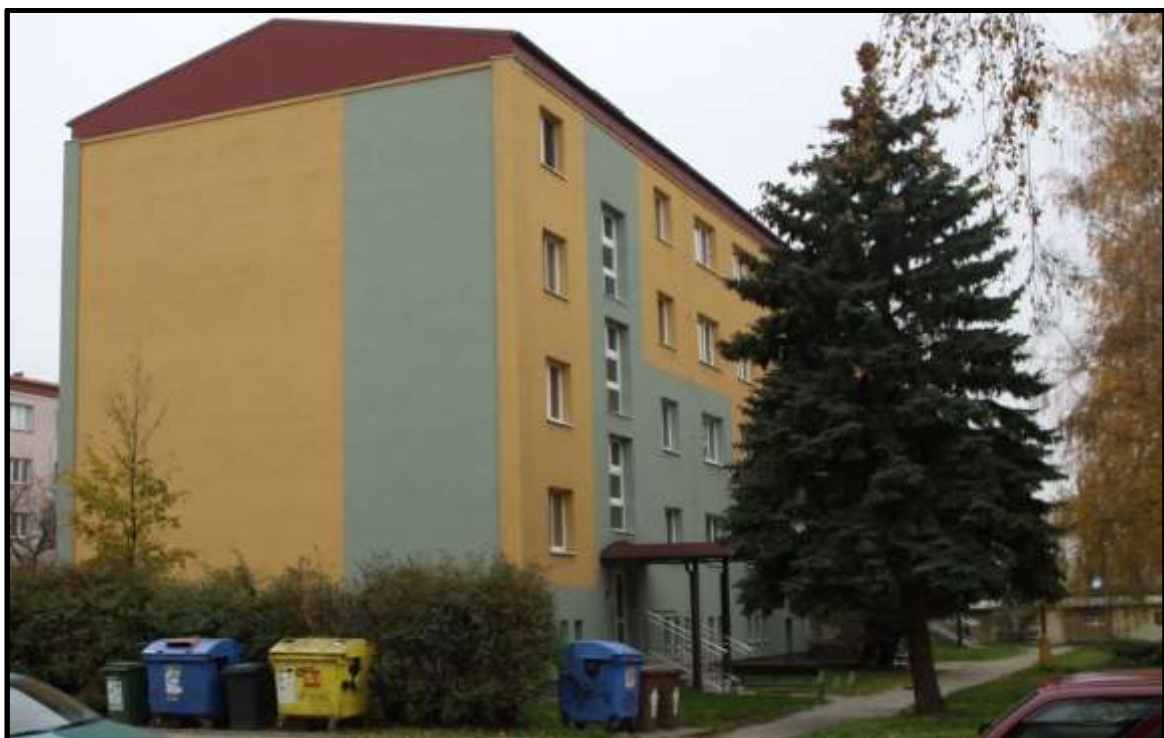
Konstrukční soustava G 57, řadová sekce. Dům po celkové revitalizaci. Adresa: Svatováclavská 981, 982 a 983.
