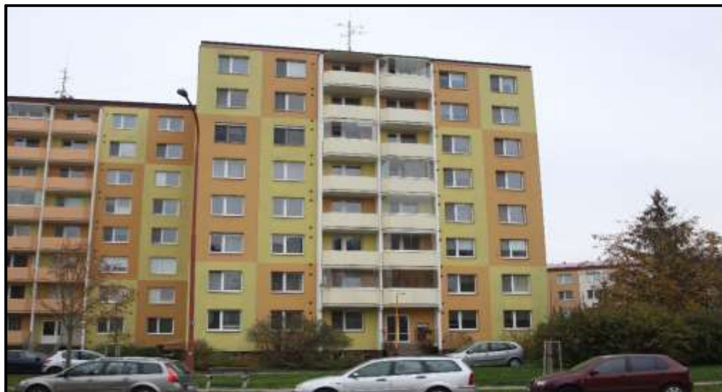
Obrázek 10 Panelový dům konstrukční řady T06B-KDU – ulice Štěpnická [33]
