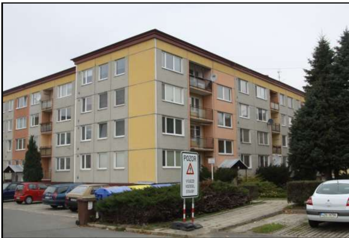
Konstrukční soustava OP 1.11, rohová sekce. Adresa: Sadová 1030. Nová sedlová střecha a provedena výměna oken.
