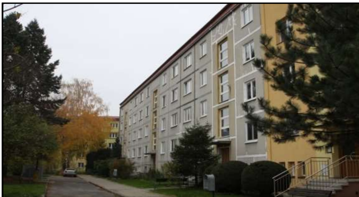
Obrázek 8 Panelový dům konstrukční řady G57 – ulice Průmyslová [33]
