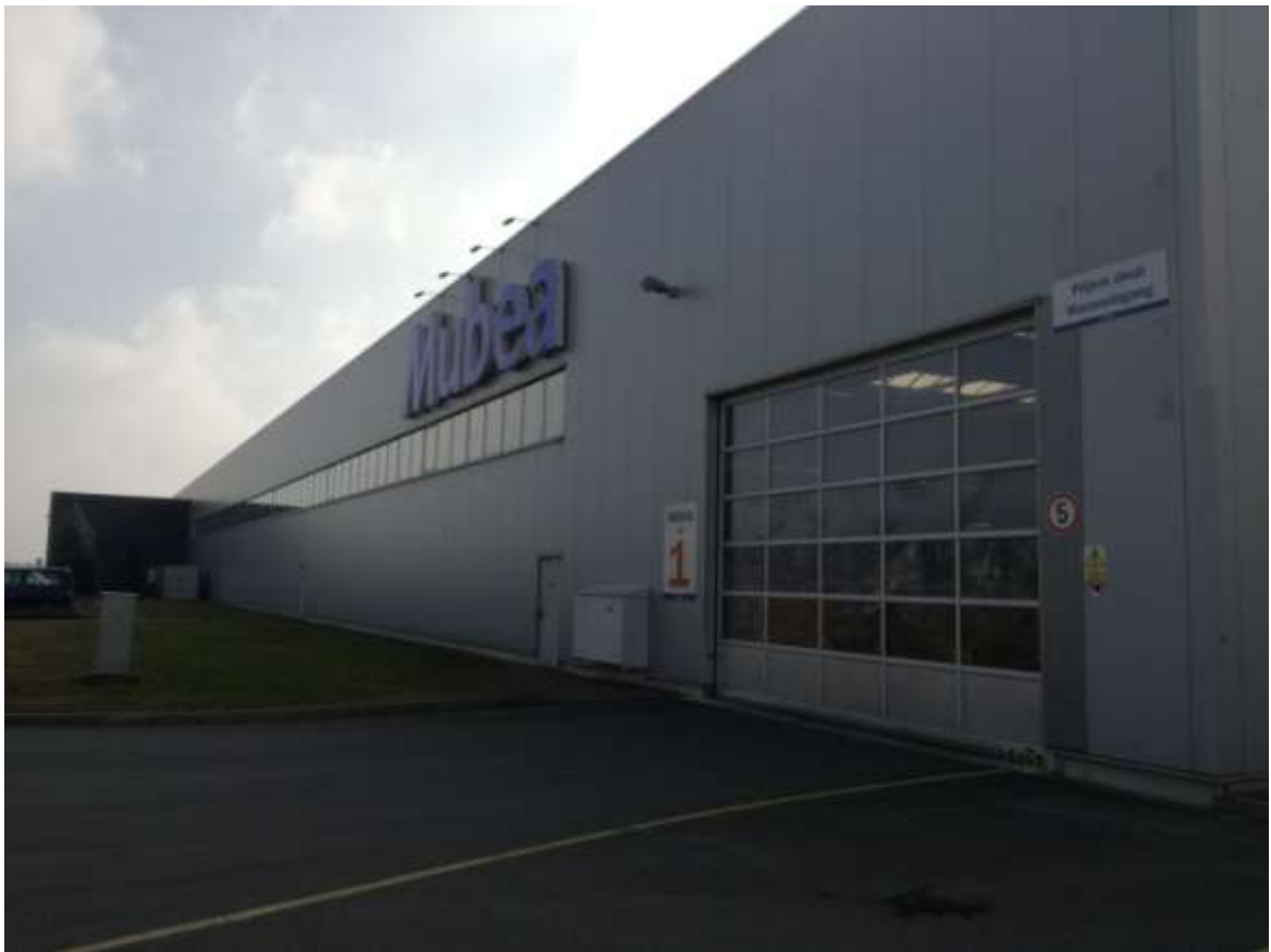
Obrázek 4 Výrobní hala 1. Zdroj: [vlastní zpracování]
