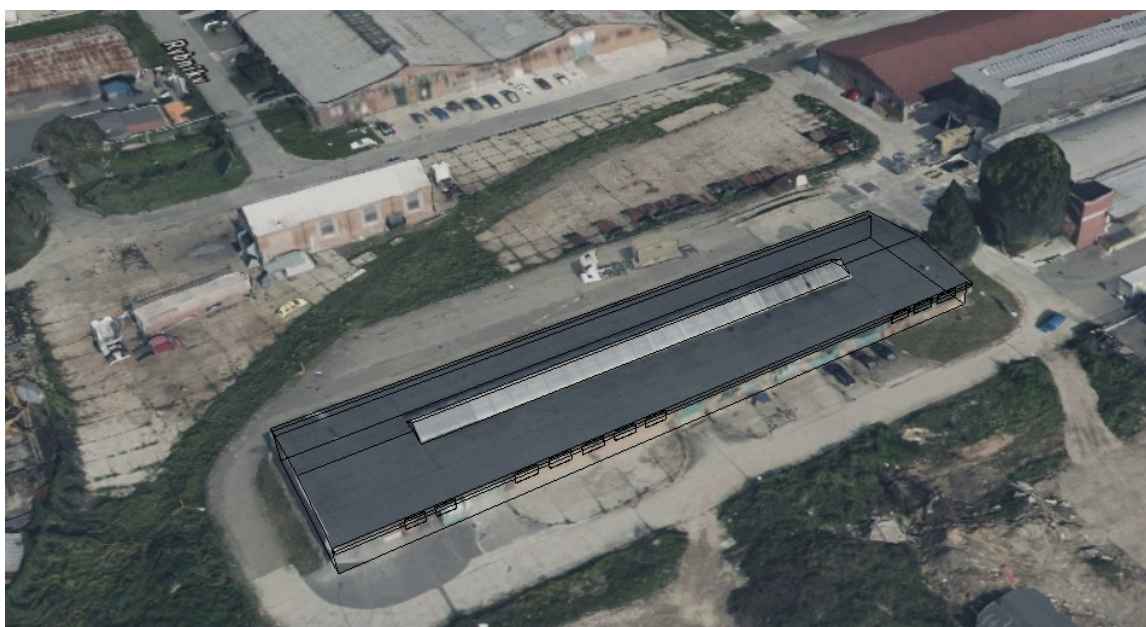
Obrázek 20 Budova č. 324 pohledem z kamery nastavené pomocí addonu Blam
