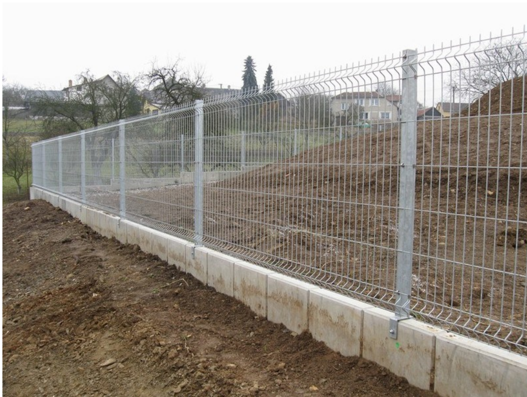
Obr. 13. Průmyslové oplocení odolné vůči podhrabání a přelezání [20]
