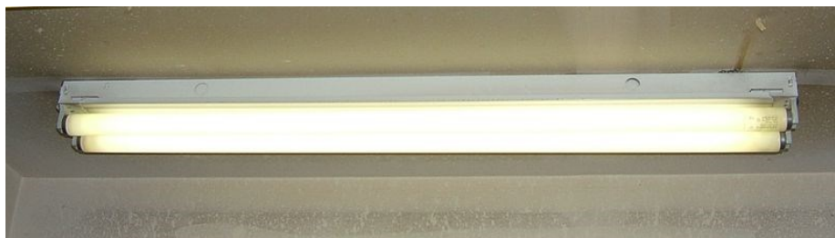
Obrázek 7 – Běžná fluorescenční trubice
