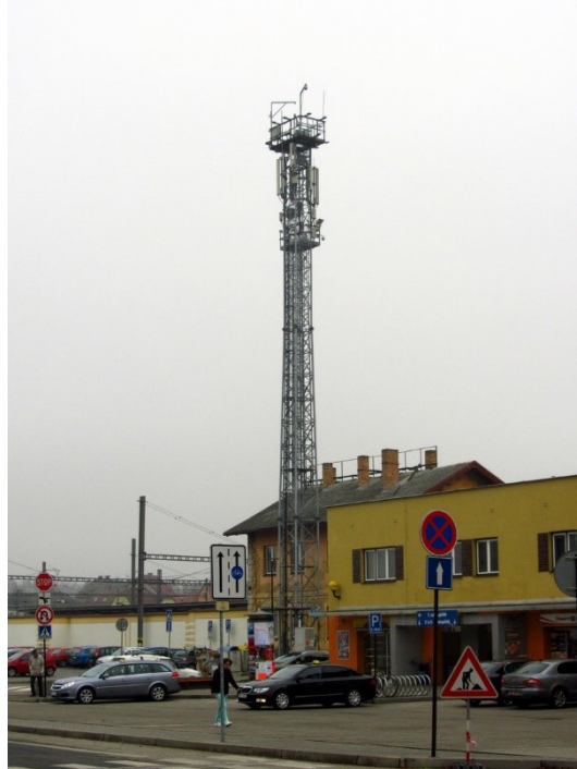
Obr. 6 - Osvětlovací stožár v železniční stanici Tábor [14]
