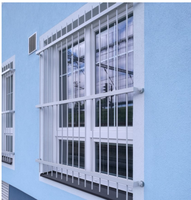
Obr. 24 – Zabezpečená okna v hlavní budově - část VI [autor]
