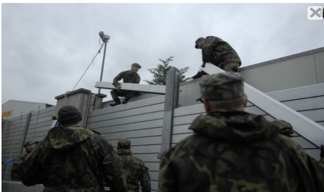
Obrázek 3: Budování protipovodňových zábran. Zdroj [31]
