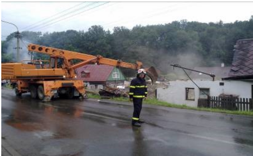
Obrázek 9 obec Chrastava, povodně 2010, demolice objektu [zdroj:19]
