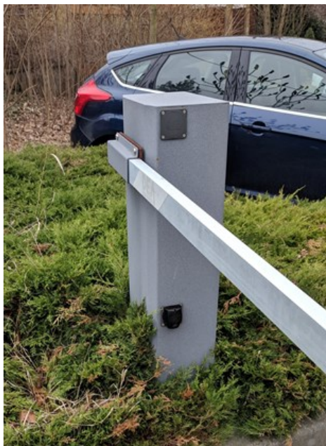
Obr. 19: Systém závory na ulici nad Ovčírnu I [zdroj: vlastní]
