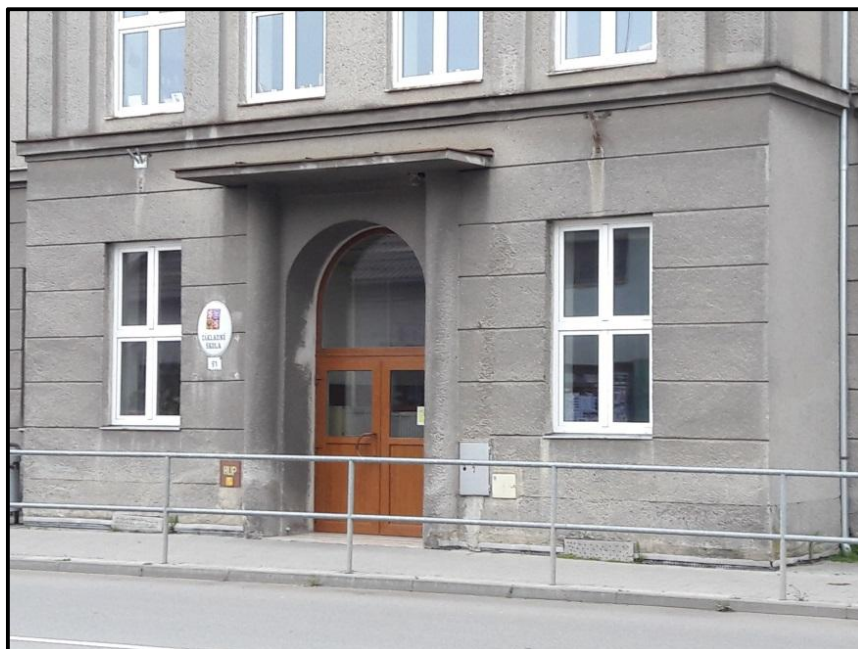
Obr. 31 Fotografie – Hlavní vchod nižší stupeň a zábradlí [vlastní]
