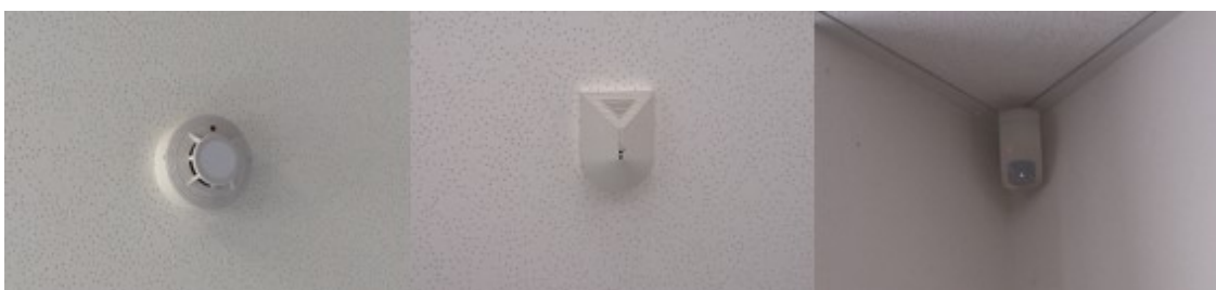
Obrázek 9 - Kouřové čidlo, rozbití skla a PIR detektor [vlastní]
