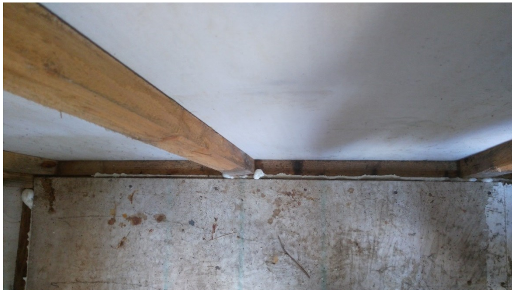
Obr. 26 Utěsněná mezera mezi podlahou a konstrukcí [Vlastní]
