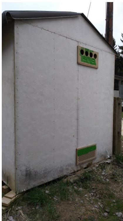
Obr. 49 Velké otvory nahoře – malé otvory dole [Vlastní]
