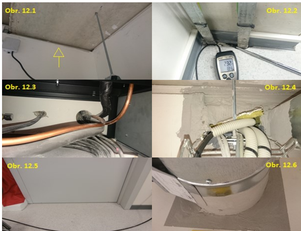
Obr. 12 Možné netěsnosti chráněného prostoru [1]
