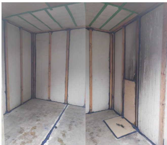
Obr. 30 Utěsnění těsnicím nátěrem BlowerProof Liquid [Vlastní]
