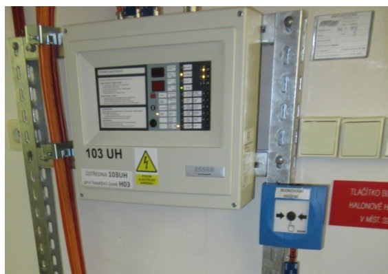
Obr. 7 Tlačítko STOP v blízkosti ústředny GHZ [Vlastní]
