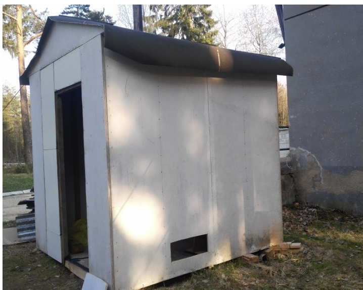
Obr. 31 Předpřipravený otvor na clony [Vlastní]
