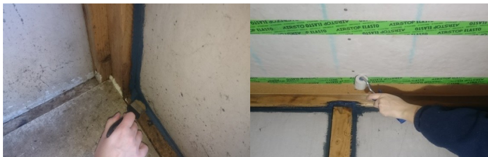
Obr. 29 Vlevo je zobrazeno utěšňování pomocí těsnicího nátěru a vpravo je zobrazena kontrola lepicích pásek [Vlastní]
