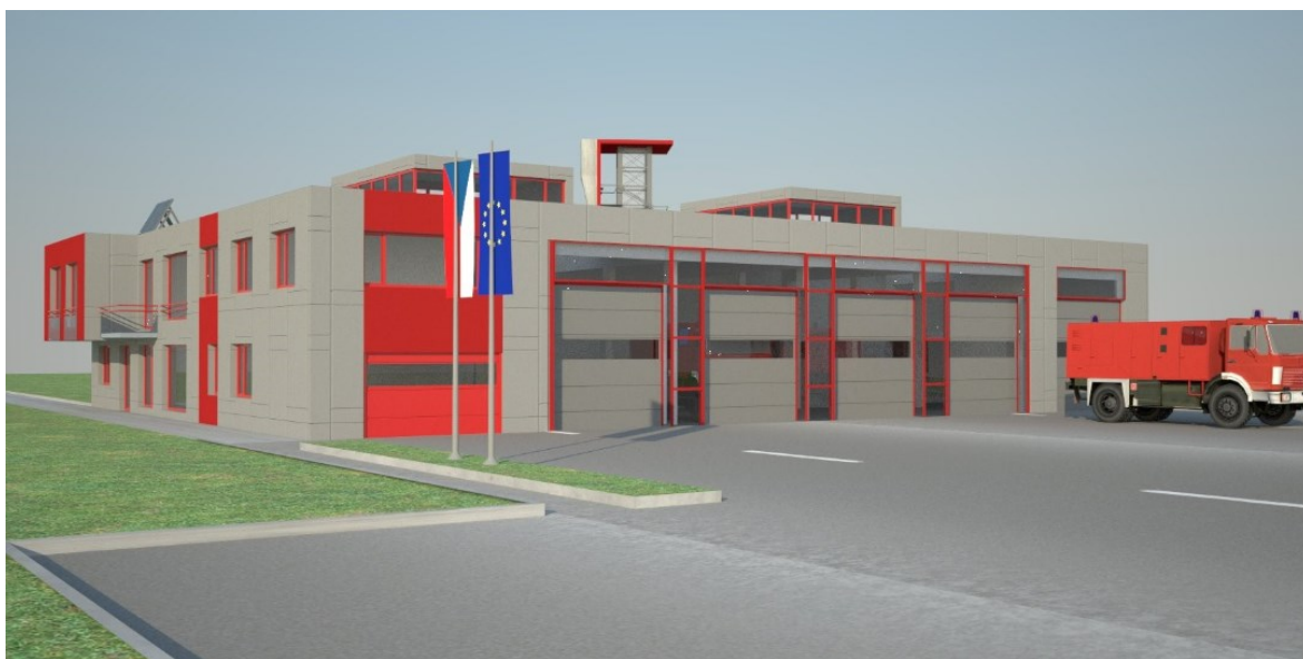
Obr. 12 – Oficiální fotodokumentace nové požární stanice Holešov [36]
