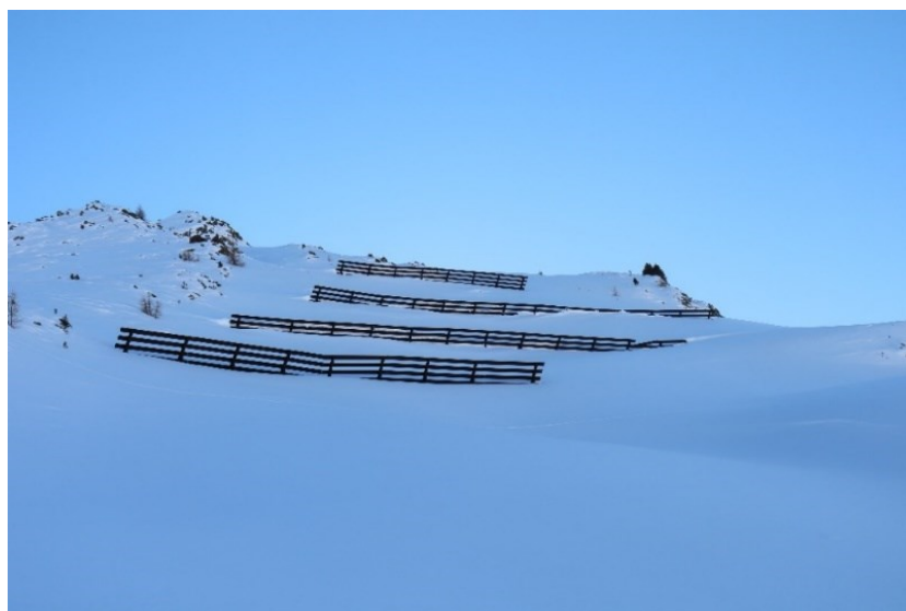
Obr. 5 – Protilavinové zátarasy. [93]
