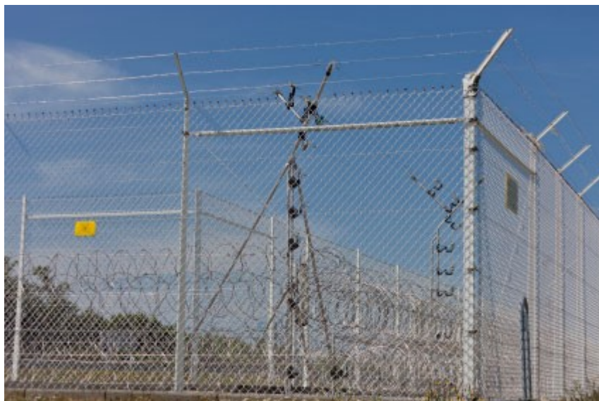
Obr. 4. Mechanické zábranné systémy [12]
