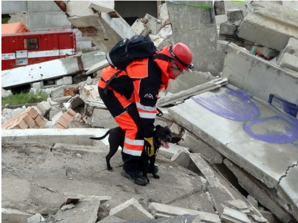
Obr. 4. Ukázka trosek budovy po zemětřesení [8]
