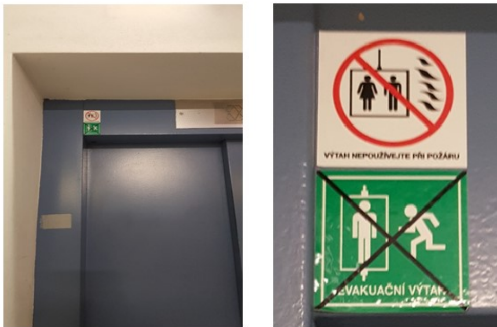
Obr. 11 Nesprávné bezpečnostní značení [autor]
