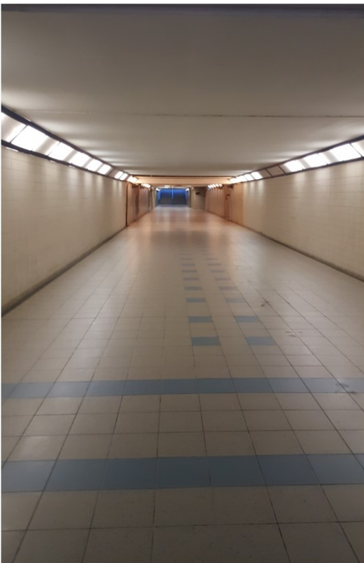
Obr. 14 Nedostatečné značení únikových východů a evakuačních cest [autor]
