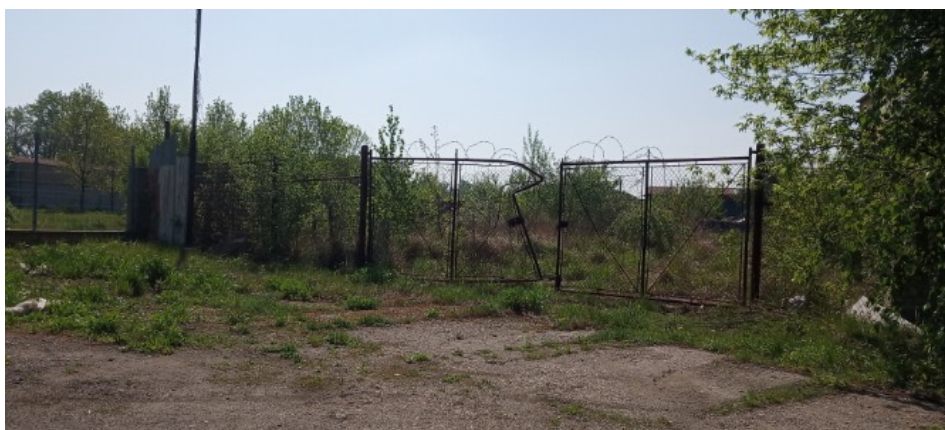
Obr. 16. Narušena obvodová ochrana zatravněné oblasti (Zdroj: vlastní)
