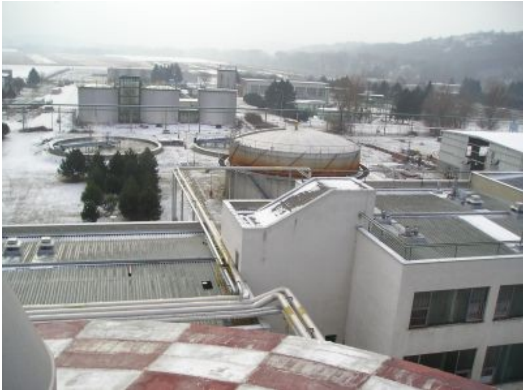
Obr. 7. Čistírna odpadních vod [31]
