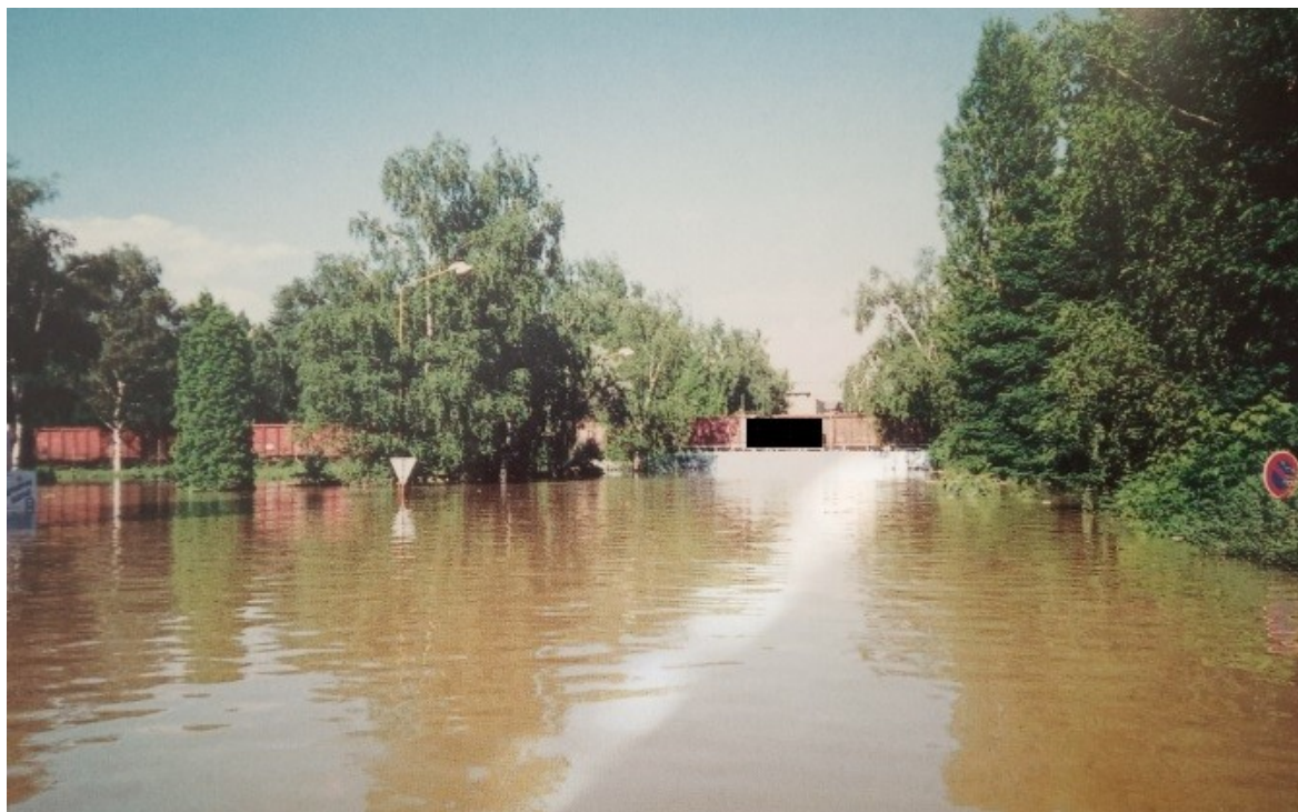
Obr. 13. Zaplavený východní vjezd do areálu [36]
