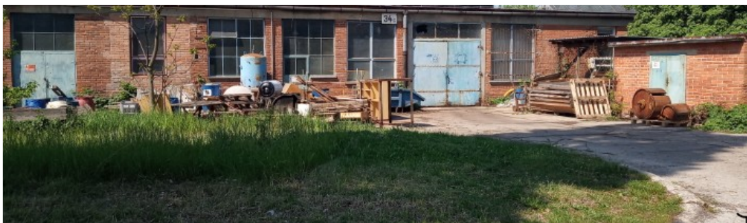
Obr. 25. Nevhodně uložené objekty u budovy střední rizikovosti (Zdroj: vlastní)
