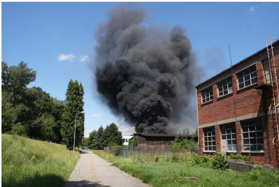
Obr. 12. Požár budovy a venkovní skládky [35]
