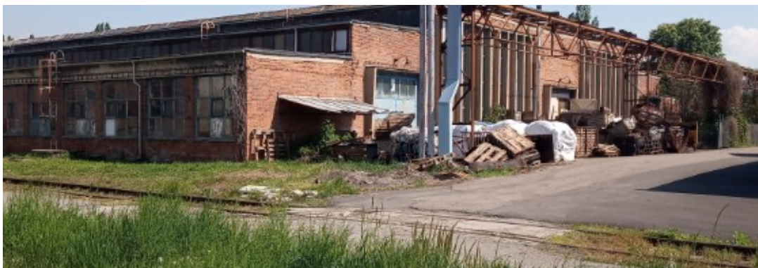
Obr. 26. Nevhodně uložené objekty u vysoce rizikové budovy (Zdroj: vlastní)
