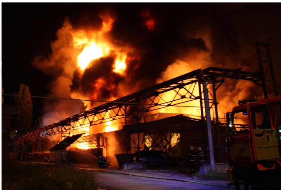
Obr. 10. Požár průmyslového objektu [34]
