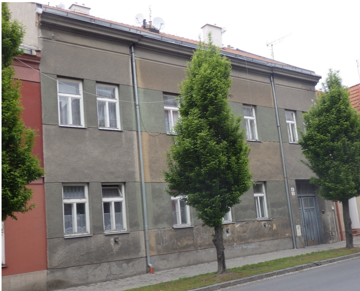
Obr. č. 2. Městský dům na ul. Palackého 507
