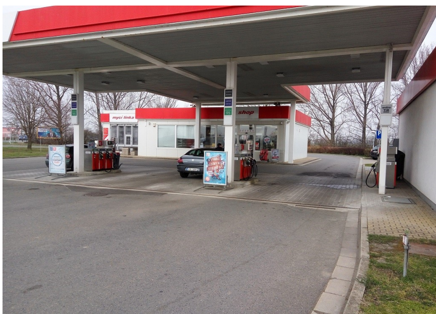
Obr. 13. Celkový pohled na čerpací stanici [19]
