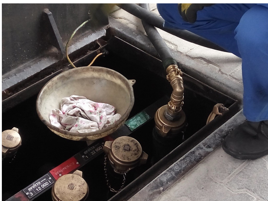
Obr. 23. Detail připojovací armatury při stáčení [19]
