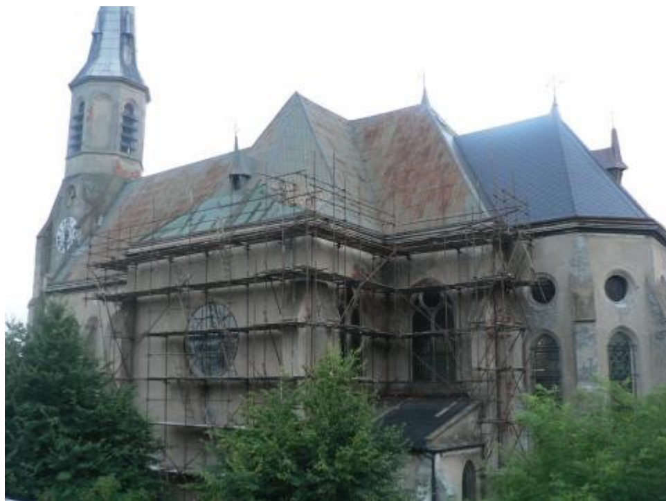
Obr. 9. Oprava střechy kostela Nanebevzetí panny Marie_2 (Toulky přerovským děkanátem, 2015)
