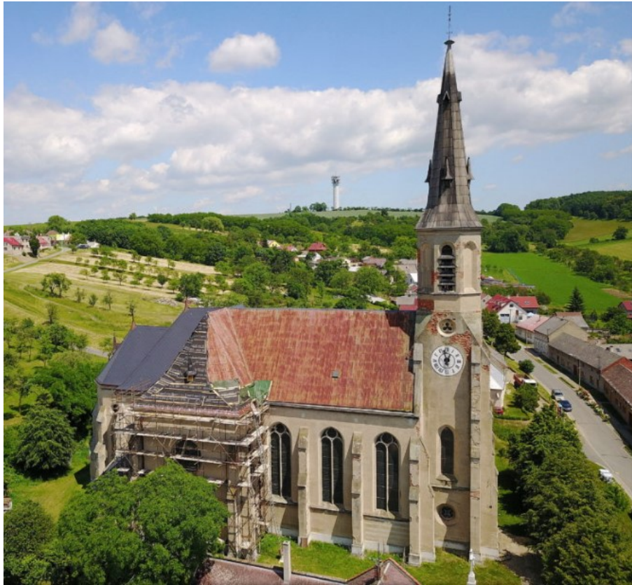
Obr. 8. Oprava střechy kostela Nanebevzetí panny Marie_1 (Toulky přerovským děkanátem, 2015)
