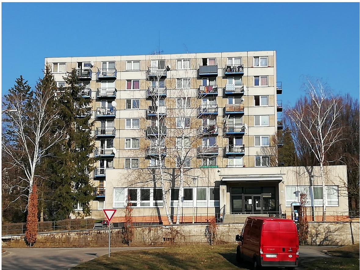
Obr. 7. Bytový dům Větrná 2060
