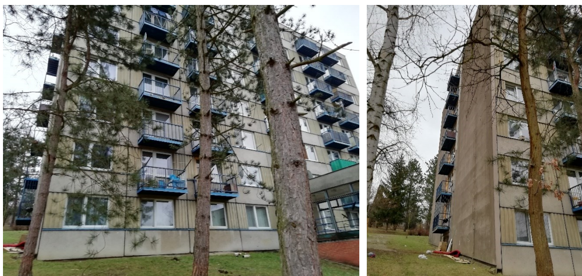
Obr. 8. Nepořádek kolem bytového domu na Větrné
