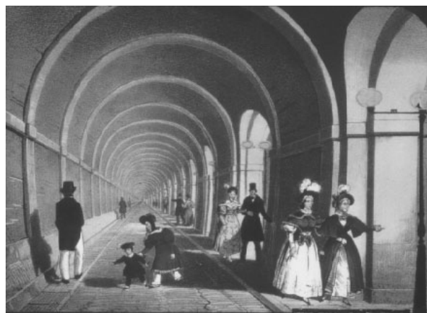
Obr. 4 – Interiér tunelu pod Temží
