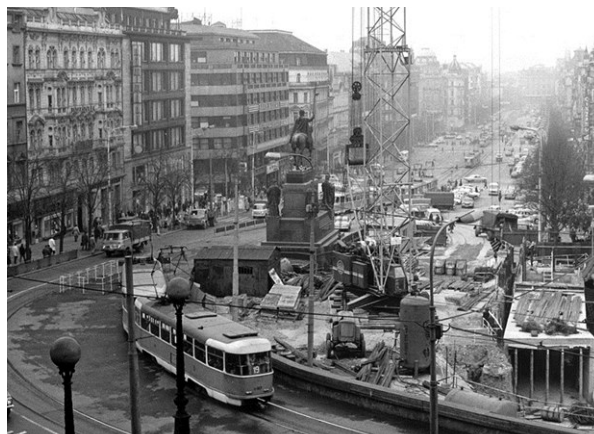
Obr. 19 – Stavba stanice Muzeum
