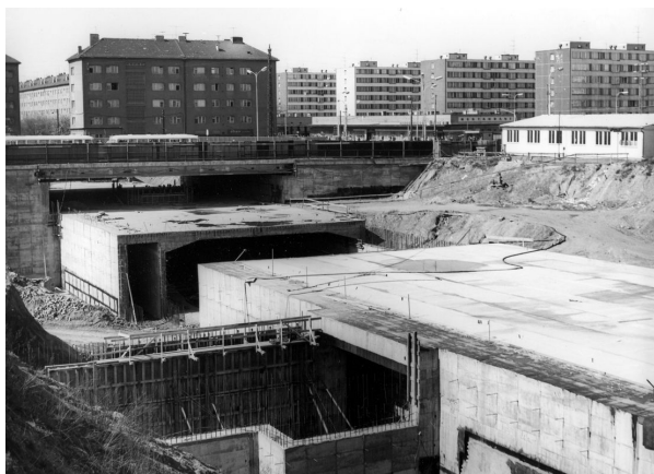
Obr. 18 – Stavba stanice Budějovická
