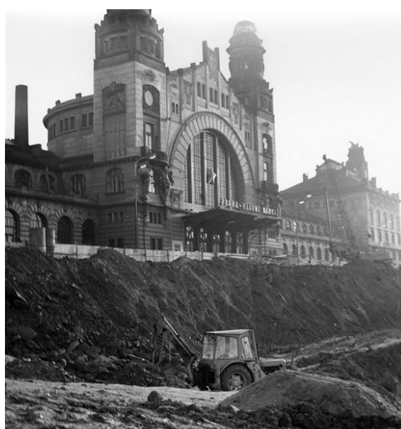
Obr. 21 – Stavba stanice Hlavní nádraží
