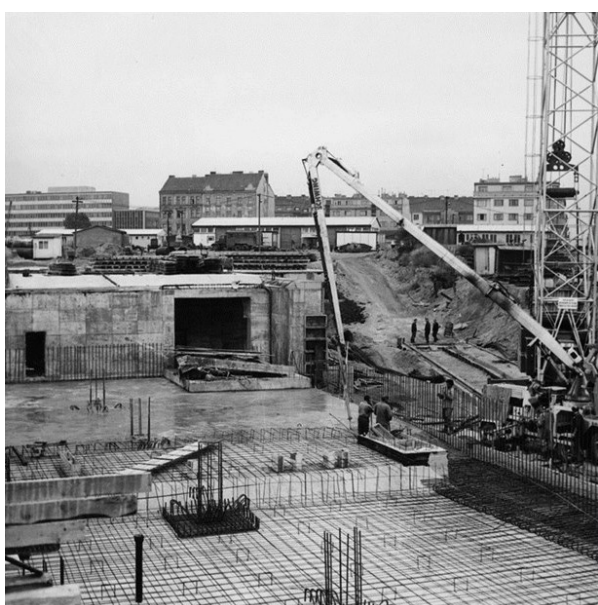
Obr. 20 – Stavba stanice Výšehrad (Gottwaldova)
