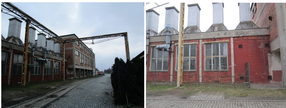
Obrázek 7 Exteriér zlínské továrny I (Zdroj: vlastní) Obrázek 8 Exteriér zlínské továrny II (Zdroj: vlastní)
