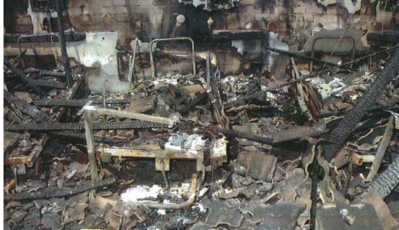
Obrázek 2 - Následky požáru domova důchodců v Quakers Hill (The Sydney Morning Herald, 2015)
