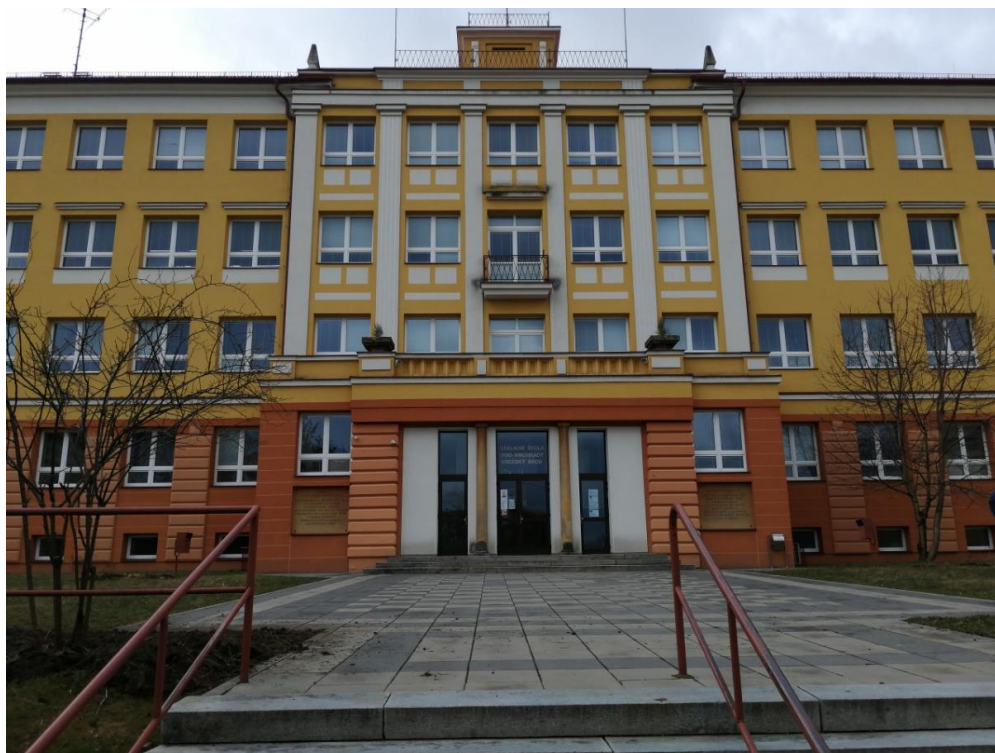
Obrázek 4 Základní škola Pod Vinohrady, vstupní vchod (Kotil, 2021)
