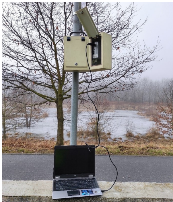
Obrázek 25 – Instalace a příprava dopravního sčítače v Otrokovicích, na ul. K. Čapka
