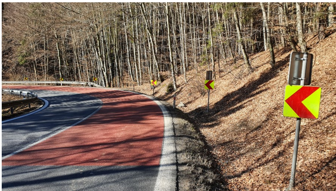
Obrázek 14 – Současný stav silnice I/69 pod vrcholem Syrákov, březen 2021
