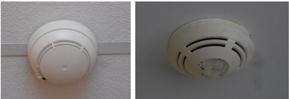
Obrázok 2: Požiarny hlásič [Vlastný zdroj]
