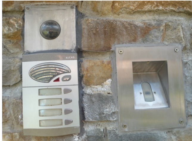
Obrázok 8: Video zvonček a snímač odtlačku prsta [Vlastný zdroj]
