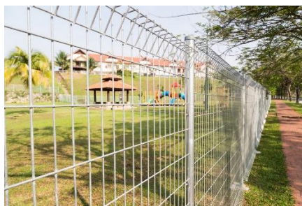
Obrázek 7 – Příklad panelového oplocení [21]
