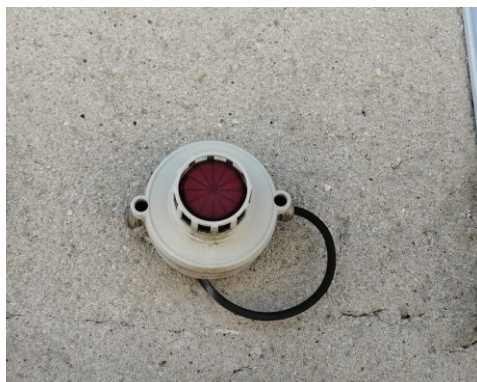
Obrázek 4 - Indikátor a hlásič požáru v objektu čerpací stanice (zdroj: vlastní).
