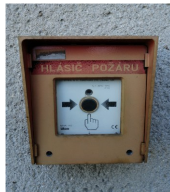
Obrázek 4 - Indikátor a hlásič požáru v objektu čerpací stanice (zdroj: vlastní).
