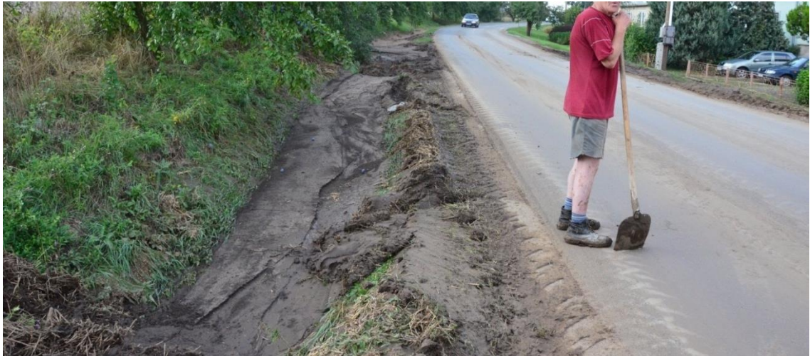
Obrázok 19 Naplavené bahno v rigole strom na Gbely. [32]
