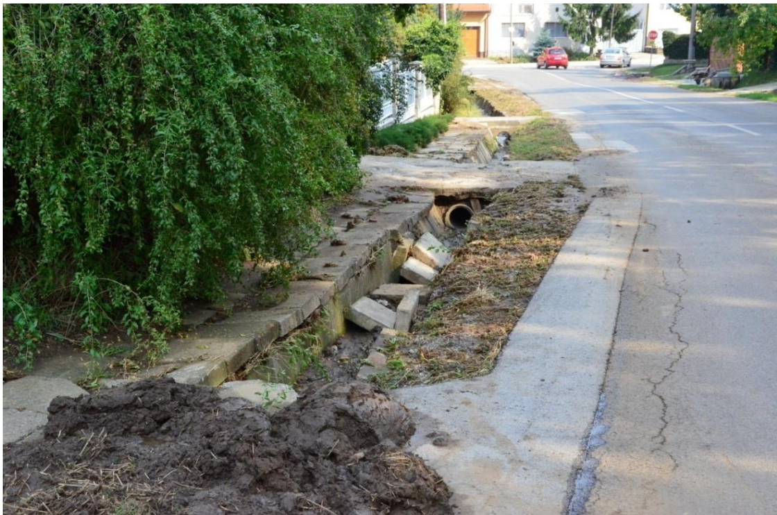
Obrázok 20 Zničený rigol po povodniach. [33]
