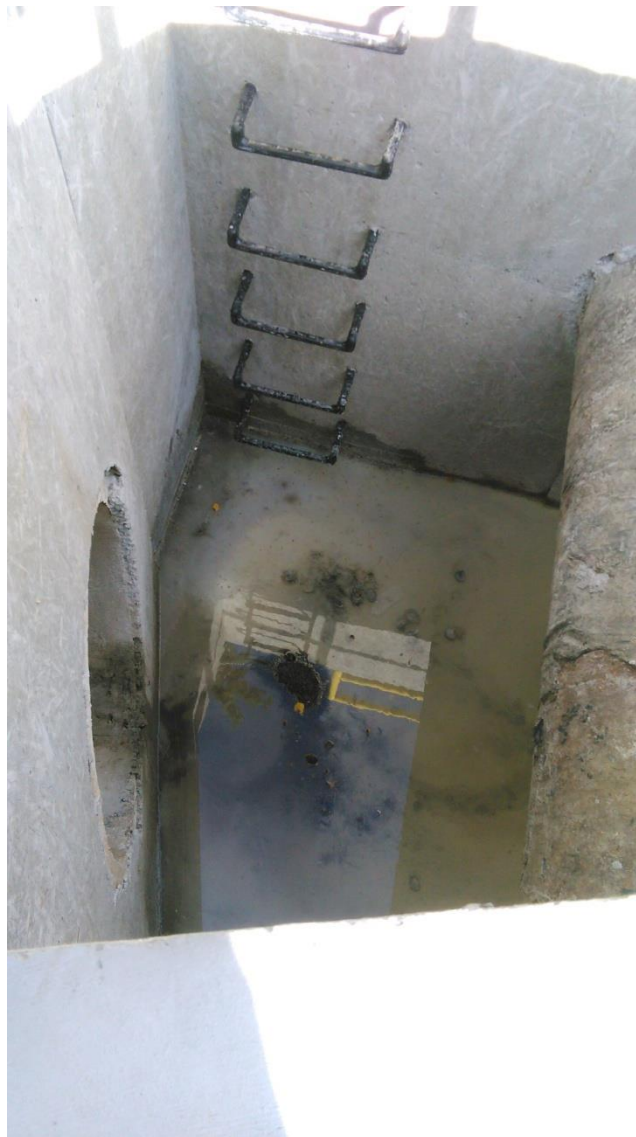
Obrázok 11 Lapač splavenín. [Zdroj: Autor]
