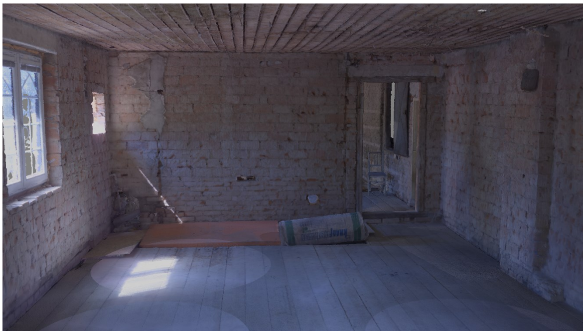
Obrázok 51. Interiér budovy – 2. poschodie – malá miestnosť b)
