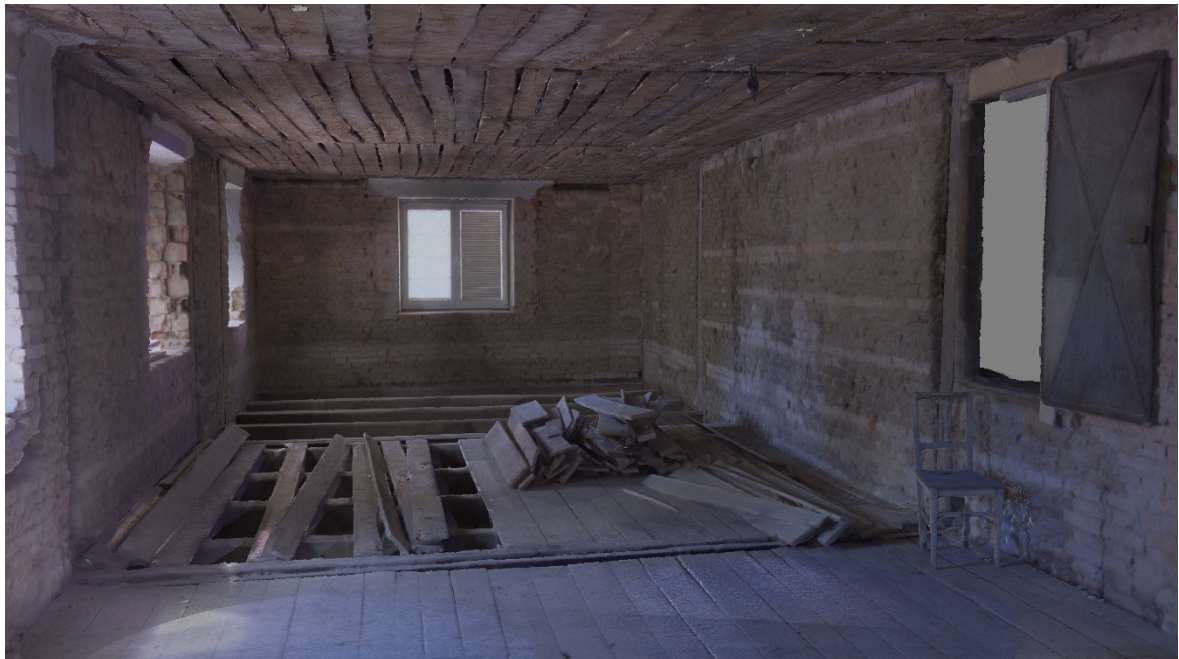
Obrázok 49. Interiér budovy – 2. poschodie – veľká miestnosť
