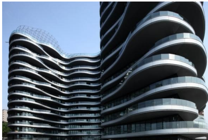
Obr. 8: Bytový dům Oceán, Taipei Taiwan
