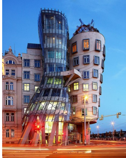
Obr. 5: Tančící dům Praha
