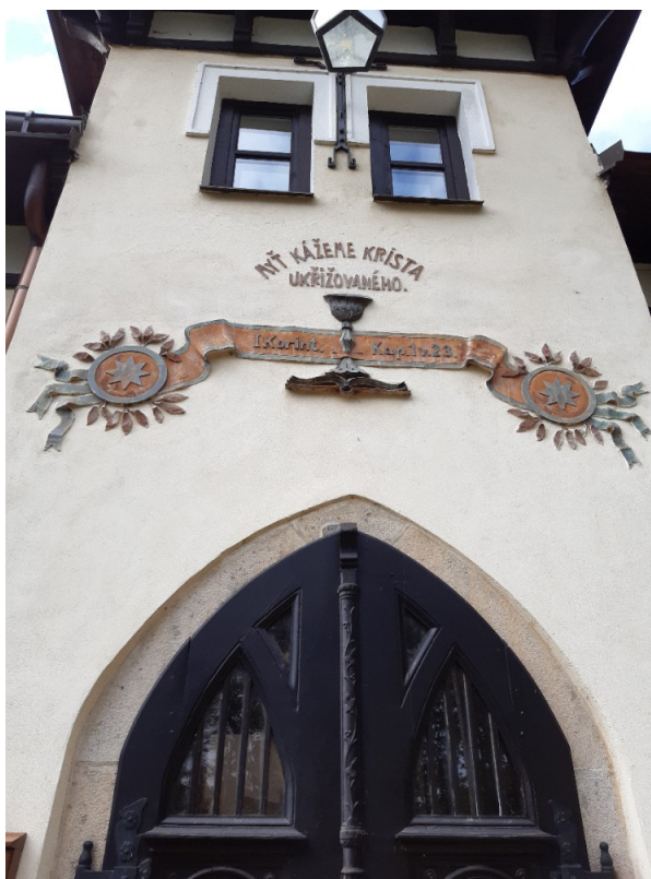
Obrázek 61: Jindřichův Hradec, symboly na fasádě kostela (zdroj: Archiv ČCE)
