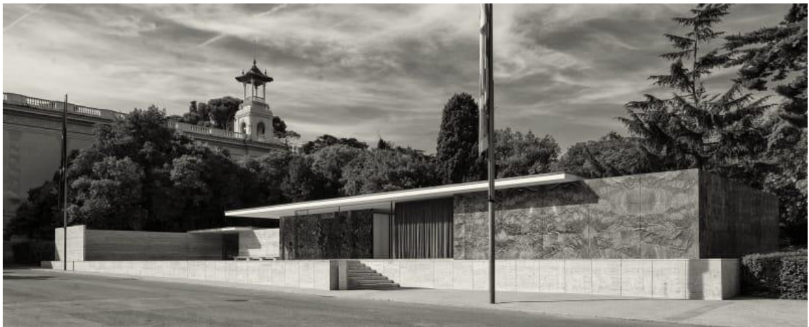
Obr. 5. Nemecký pavilón (1929-1930), EXPO Barcelóna
