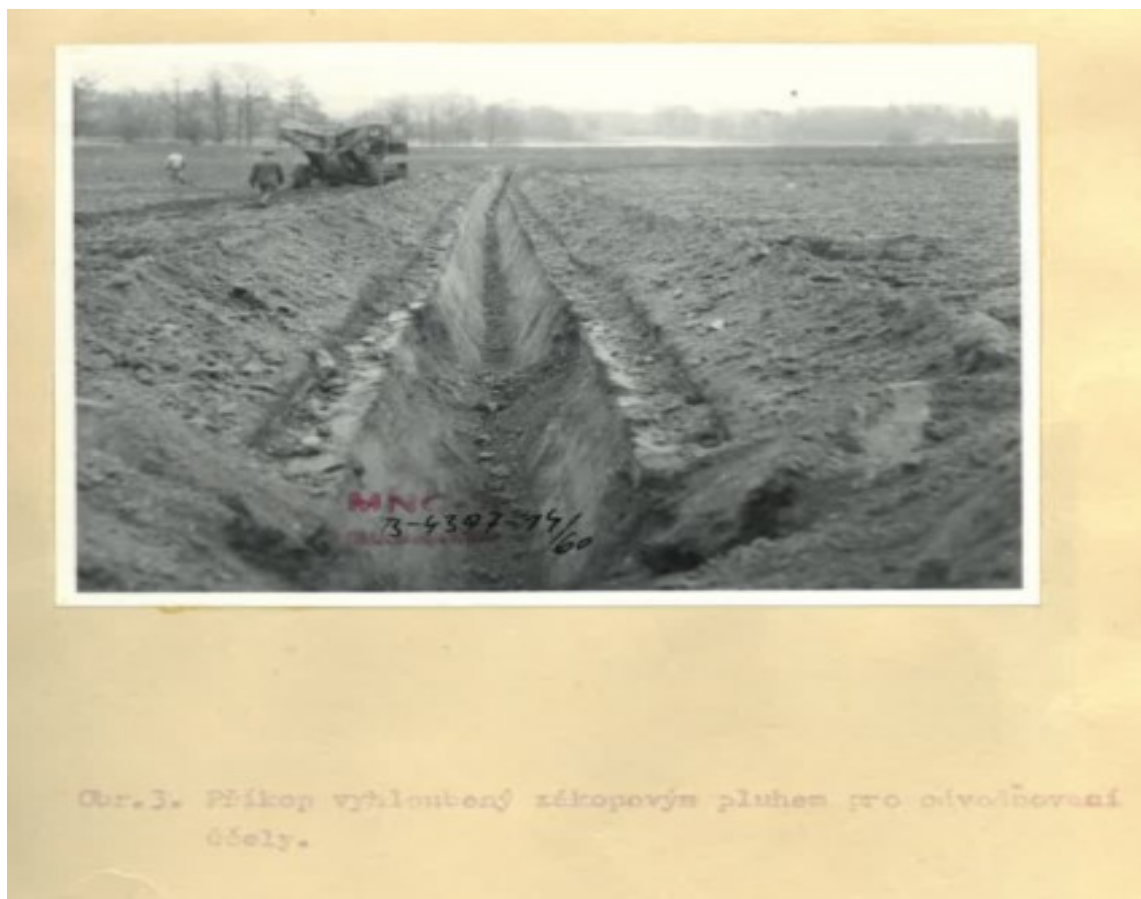
Obrázek 9 Příkop vyhloubený ZP 60/90 pro odvodňovací účely Zdroj: [archív autora]
