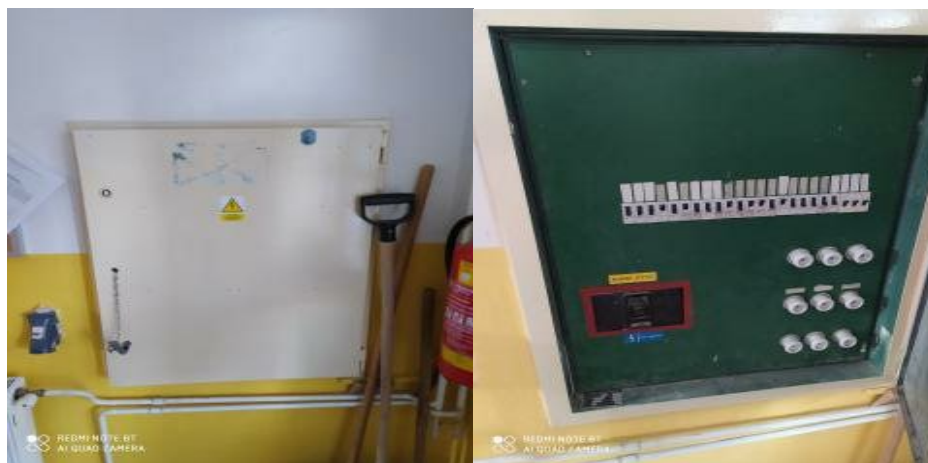
Obrázek 13 - Hlavní jistič [vlastní]
