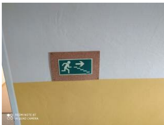
Obrázek 17 - Evakuační značení umístěné před schodištěm [vlastní]
