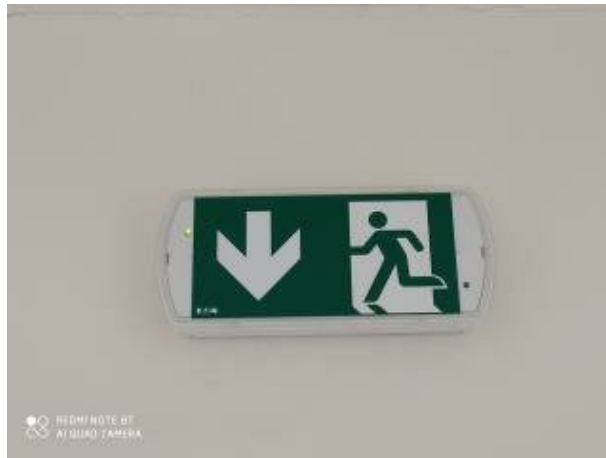
Obrázek 18 - Nouzové osvětlení [vlastní]
