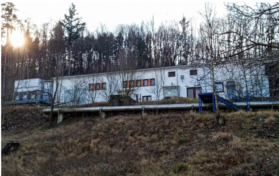
Obr. 5 – Strojovna chlazení [Zdroj: vlastní]
