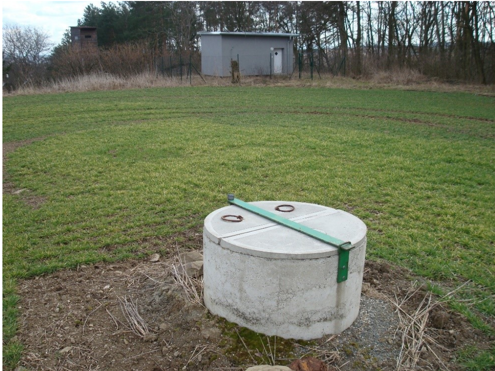
Obr. 14. Posilový vrt HVP 1 v pozadí s přečerpávací stanicí
