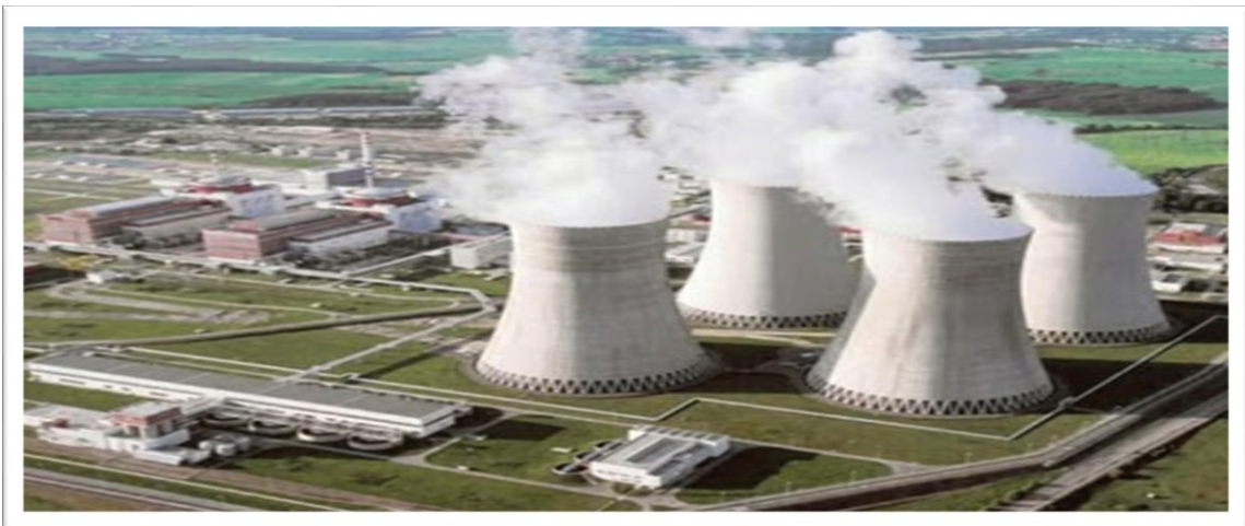
Obr. 11: Jaderná elektrárna Temelín [40]
