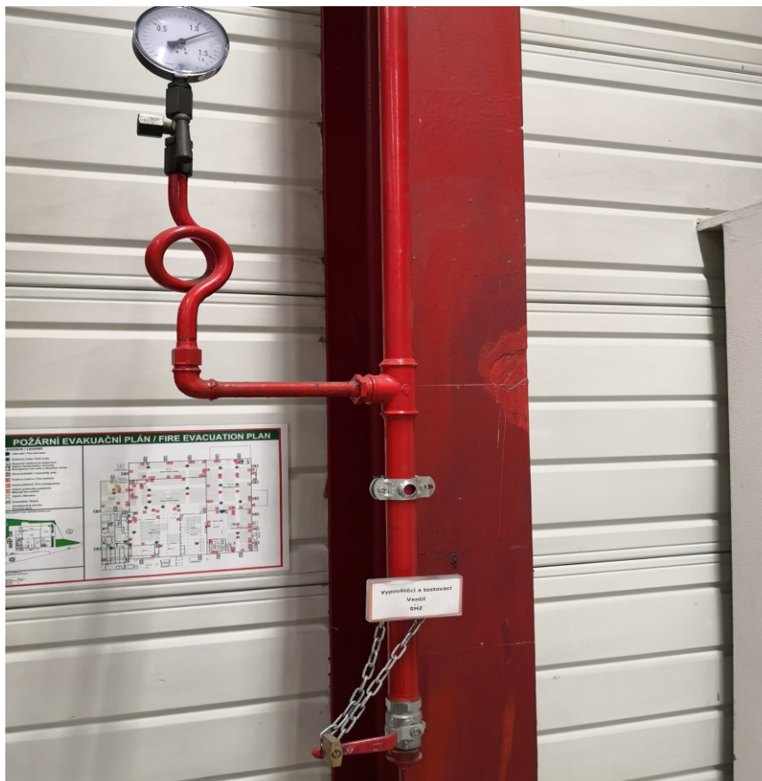
Obr. 6. Vypouštěcí a testovací ventil SHZ [zdroj: vlastní]
