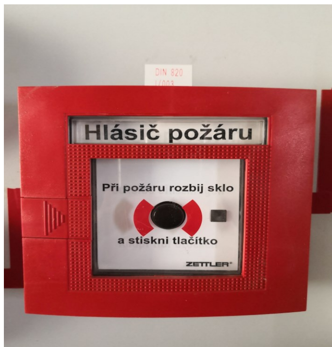
Obr. 2. Tlačítkový hlásič EPS [zdroj: vlastní]
