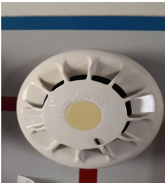
Obr. 3. Optický hlásič kouře [zdroj: vlastní]
