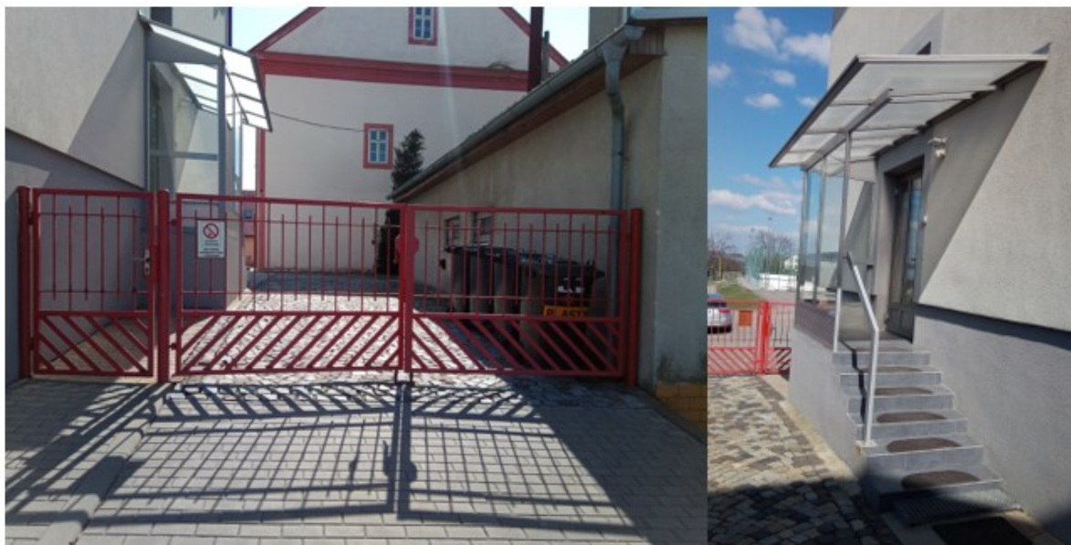
Obr. 13 – Průchod mezi budovami a služební vchod [vlastní]
