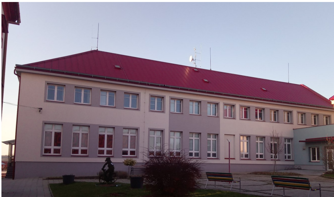
Obr. 9 – Budova II. směrem k nádvoří (vpravo spojovací krček) [vlastní]
