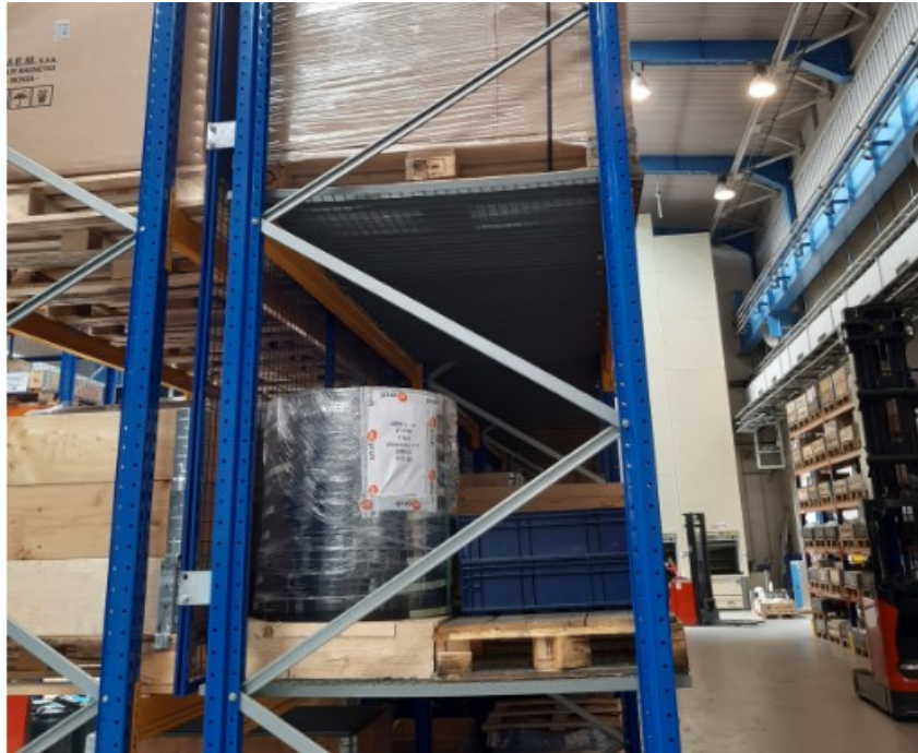
Obr. 17 Stav po instalaci bezpečnostních sítí [vlastní]
