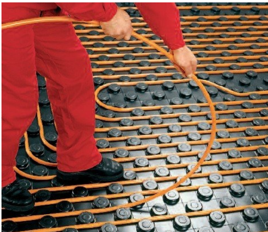
Obr. 12 Pokládání trubek podlahového vytápění – maximální tlak uvnitř trubice je 10 barů [27]
