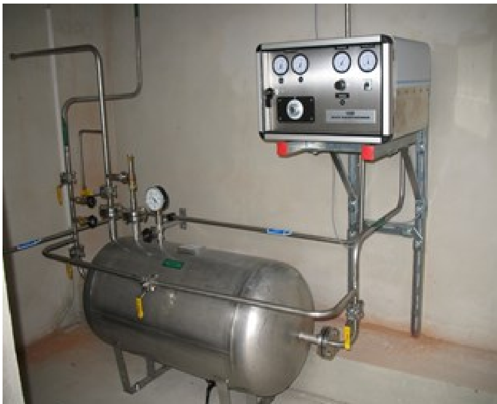
Obr.11. Směšovač plynů a zásobník směsi plynů [39]
